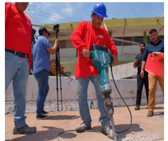
Rehabilitación de la Alberca Olímpica del Deportivo Alvaro Obregón en Cajeme
