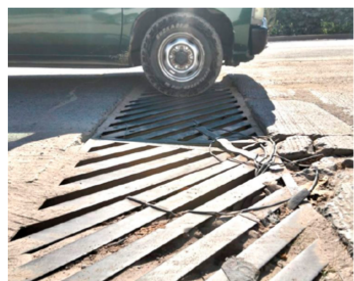
Alcantarilla en mal estado en la avenida Federación representa un riesgo para automovilistas en Puerto Vallarta
