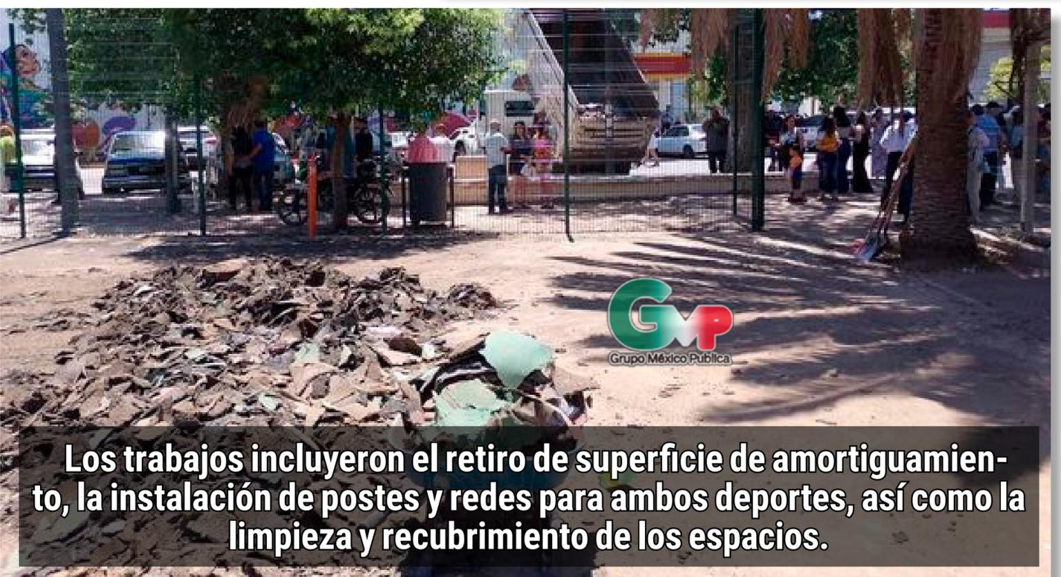
Los trabajos incluyeron el retiro de superficie de amortiguamiento, la instalación de postes y redes para ambos deportes, así como la limpieza y recubrimiento de los espacios.
